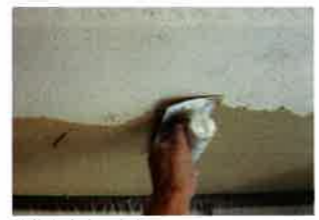
珪藻土漆喰で完全に覆うことで、カビの 発生した壁にそのまま施工できる
