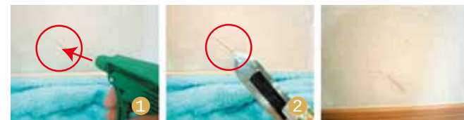
キズの補修は先に霧吹きでたっぷり水をかける 1 2 補修部分のまわりについた材料を拭き取り終了
