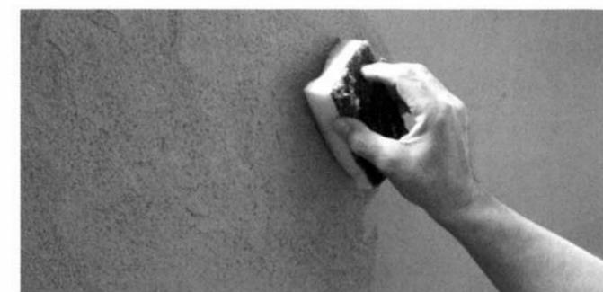
左写真-①、②でつけたワラの面が多少乾いたらスポンジで半円を描くようにこすり付けます。すると、ワラが表面に出てきて表情が完成します。材料がスポンジについたら水洗いして下さい。ただし、水切りをタオルなどでよくしておかないと、材料に水がついてしまい、色ムラの原因になりますのでご注意ください。
