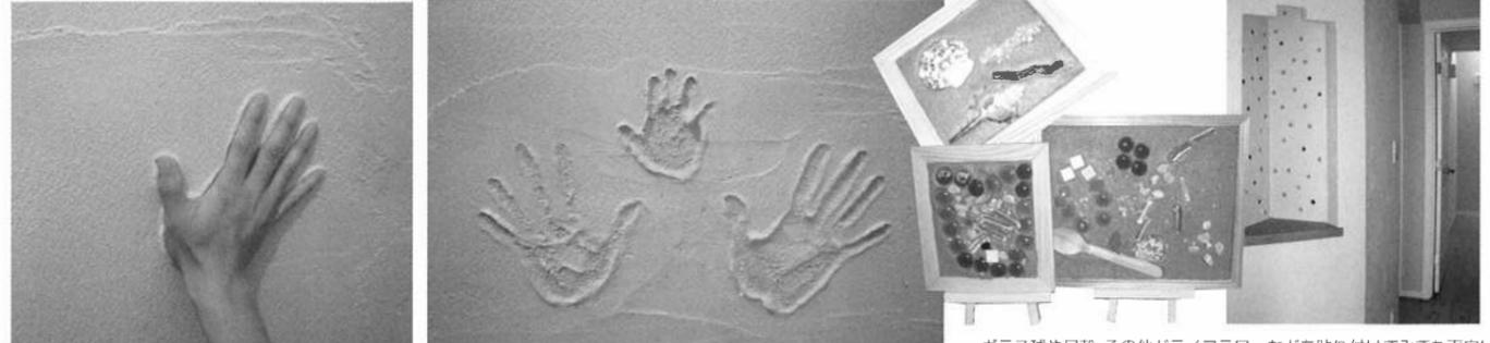
金こてでほぼ平らにした後、手形を付けた場所に手をしっかりと押さえつけます。手形を付ける場所は、少し厚めに塗っておいて下さい。手を離すと、一気に剥がすと材料が付いてきますので、少しそのままにしてゆっくり少しずつ離します。
