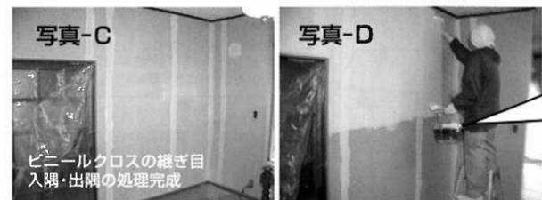
ビニールクロスの継ぎ目、入隅・出隅の処理が完了したら、J-1シーラー(ビニールクロス用シーラー)を全面にローラー・ハケ等で塗りし(写真D)24時間かけて完全乾燥させて下さい。
