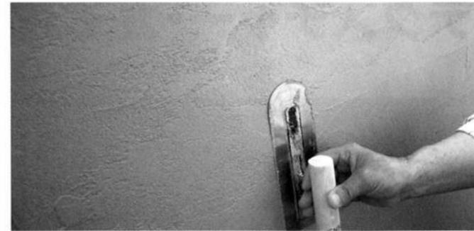
金こてを少し浮かして、材料の粘りを感じながら横へ引くと、材料がこてに引っ張られる部分(さざくれ状)と平らになる部分がランダムに出る模様を表現することが出来ます。
