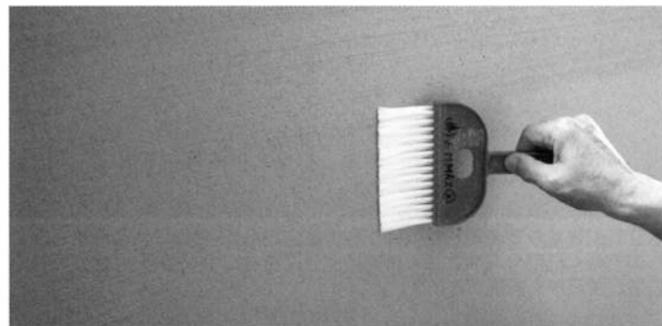
金こてで、ほぼ平らにした後、写真のようにハケを寝かせながら横に引いていきます。ハケの角度でハケ溝の深さが変わります。ハケ目は寝かせれば柔らかく、立てれば荒く表情が出ます。
