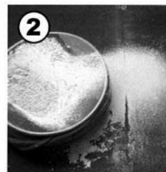
2 次に施工した同じ粉をふるいにかけて。目が細ければ細かい方がいいです。小さいキズの補修であれば、さらにパンストのように目の細かいものでふるいます。骨材などが全て取り除かれた微粉末の粉だけを使います。
