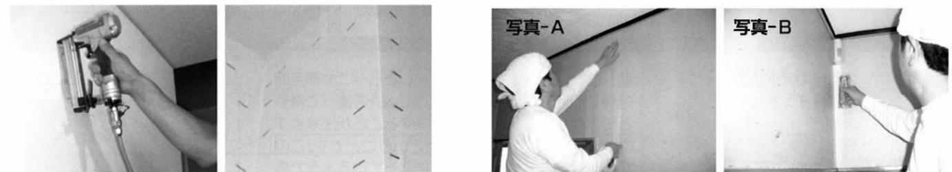
ビニールクロス剥がさないで施工する方法があります。ビニールクロスの継ぎ目や剥がれてタッカーを入れた箇所は、1cm位の短いピッチでタッカー留めをして下さい。ビニールクロスの付着力にも異なりますが、10~30cm間隔でタッカー留めをして下さい。剥がれかかったクロスやチリから出たビニールクロスはタッカーできれいに整えて、剥がれてしまった箇所は裏紙まできれいに取って下さい。
