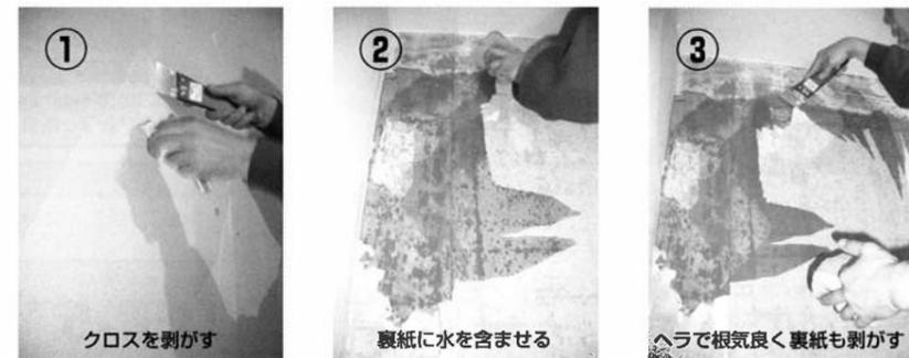
ビニールクロス剥がします。ビニールクロス剥がすと必ず裏紙が残ります。この裏紙に水を付けながらきれいに取り除いて下さい。裏紙が残っていると、シーラー処理してもその残っている部分だけ珪藻土を塗って乾燥すると、膨らんでくる場合がありますので、きれいに裏紙を取り除いて下さい。
