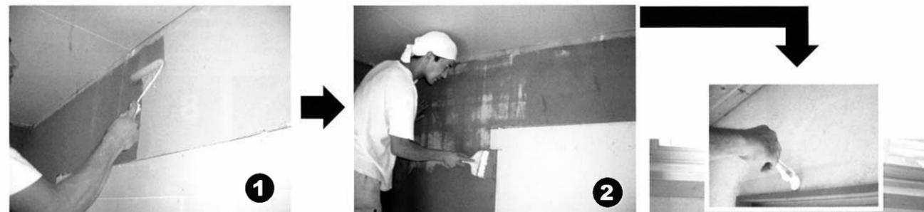
塗り壁の上に剥離剤を塗って、塗り壁を剥がしやすくします。
