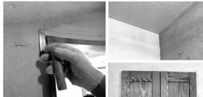
写真の様にコテで軽く1~2cm幅でラインをつける仕上げ方法もあります。額縁のアクセントを希望される場合に施工してください。
