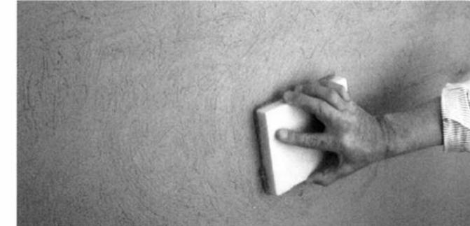
金こてでほぼ平らにした後、左の写真のように水引を確認した後、スタイロで∞字を描くように模様を付けます。材料がスタイロについたら水洗いして下さい。ただし、水切りをタオルなどでよくしておかないと、材料に水がついてしまい、色ムラの原因になりますのでご注意ください。
