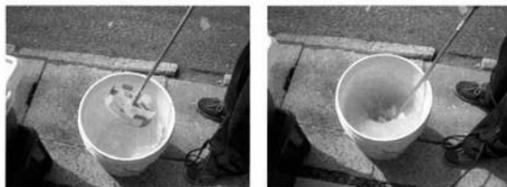
別のバケツに水を用意し、すぐに攪拌機を洗って下さい。(固まる前だと攪拌機に付着した珪藻土は回せばすぐに落ちます)
