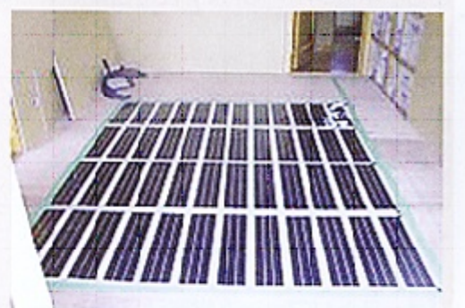
「パセロ」の施工現場。0・28mmと薄いため、 段差を気にすることなく施工できる。 トイレや洗面所など短時間利用が主となる場所 では、温度コントローラーを省略して市販の 切/入スイッチを取り付けることで、コストの 節約も可能
